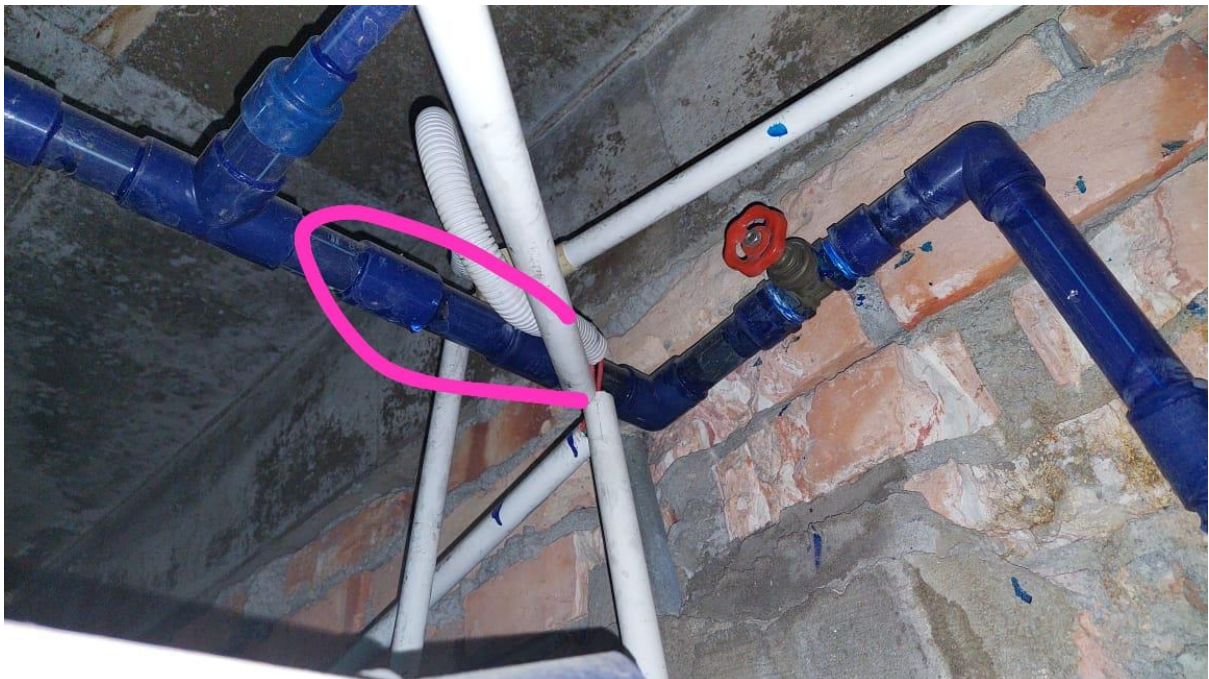
Gambar Diatas : Soket paip bocor (tandas lelaki tgkt bawah)
