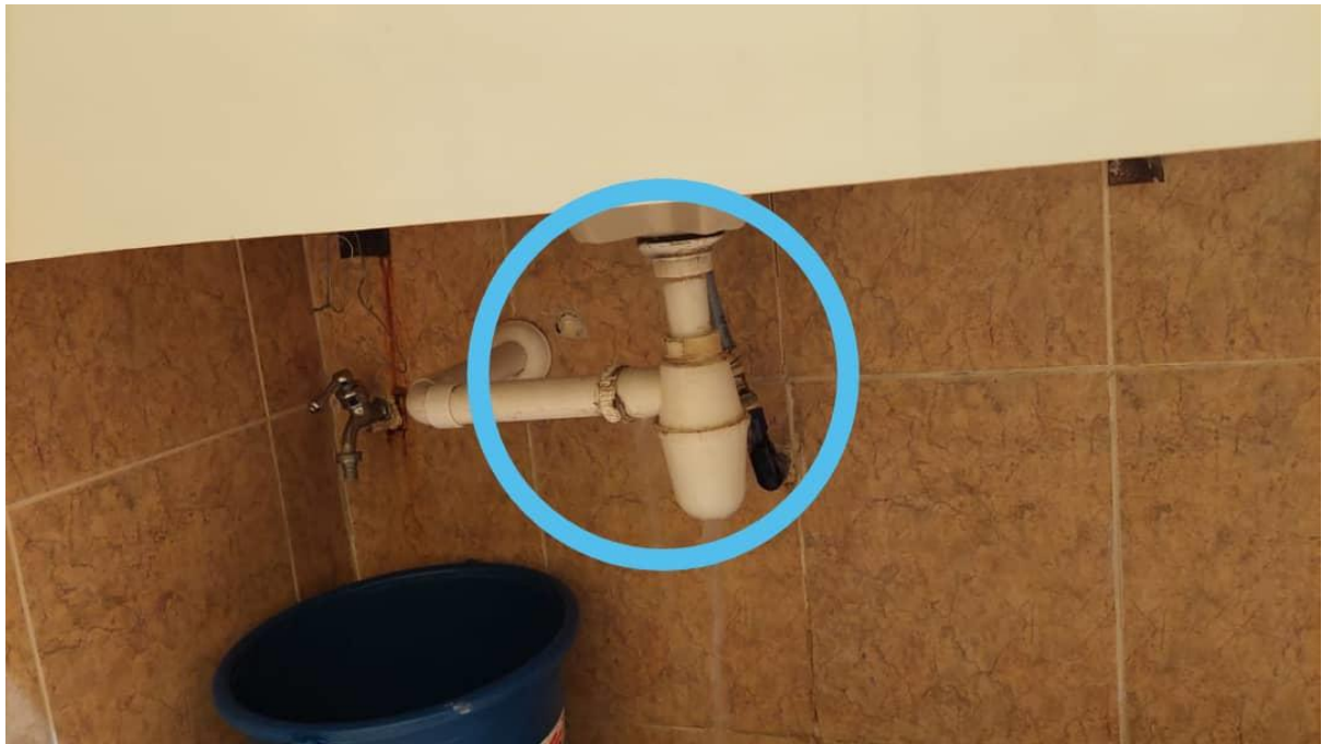
Gambar Diatas : Tray out sinki rosak - tandas L tgkt 2 (Inovasi)
