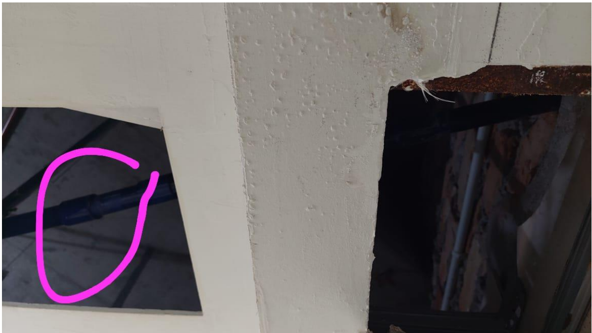
Gambar Diatas : Soket paip bocor - tandas wanita tgkt 1 (ICC)
