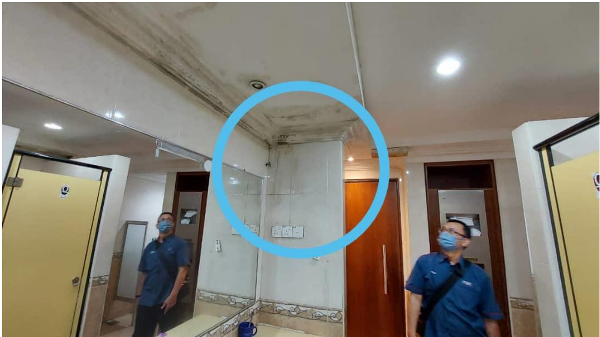
Gambar Diatas : Dinding basah - air mengalir dari dalam siling (tandas lelaki tgkt bawah)
