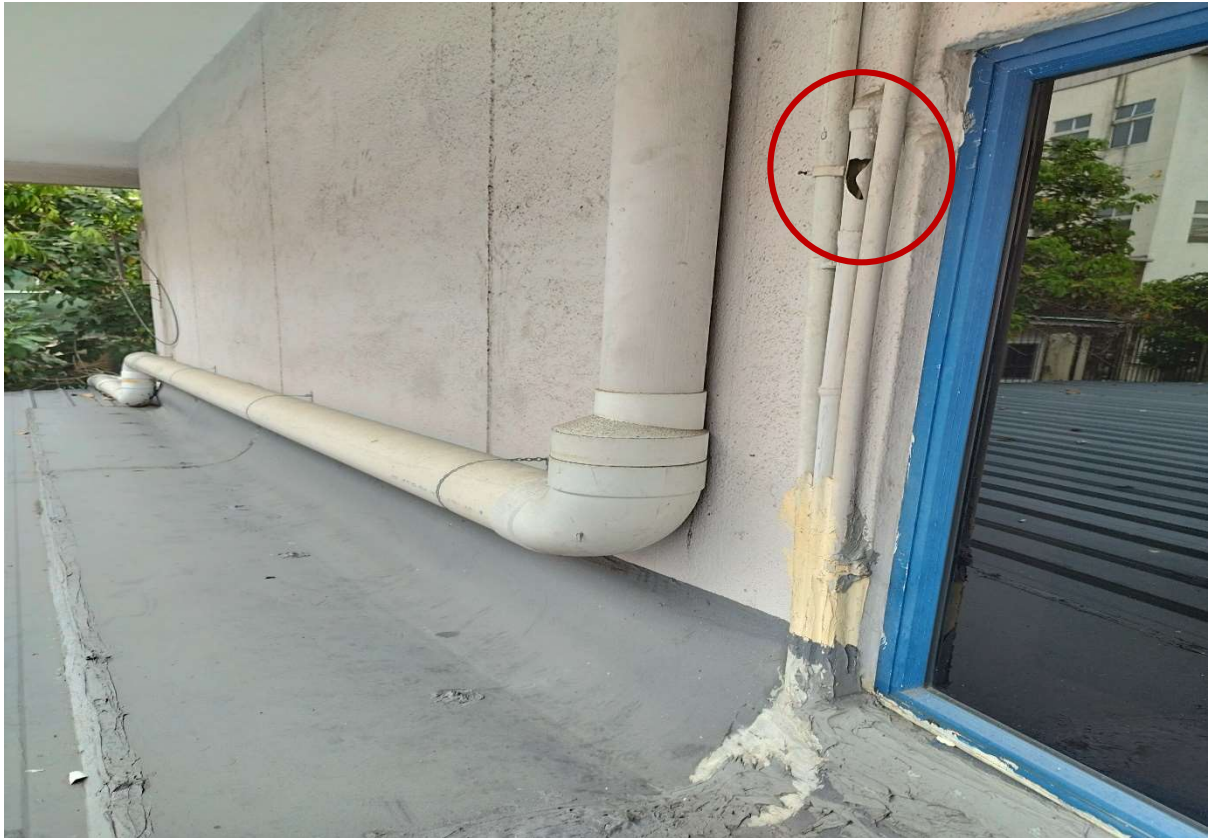
Gambar diatas (dalam bulatan) : Punca salur aircond - Daripada bilik AVA (dewan)
