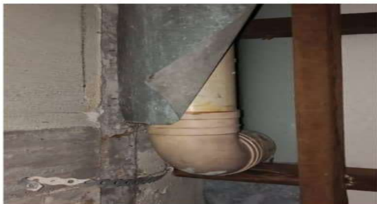
Gambar Atas : Punca - Salur Aircond bocor (Anak panah)
