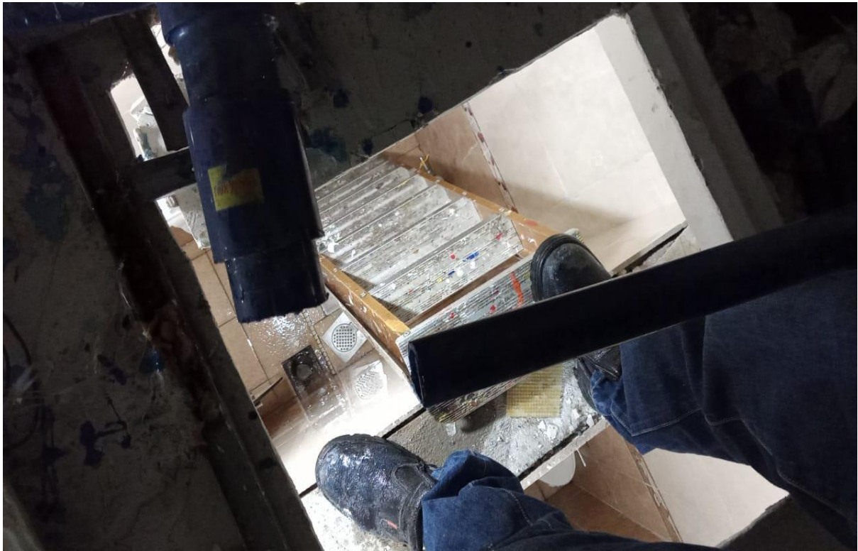
Gambar Diatas : Soket paip yang bocor di potong (pandangan dari atas)
