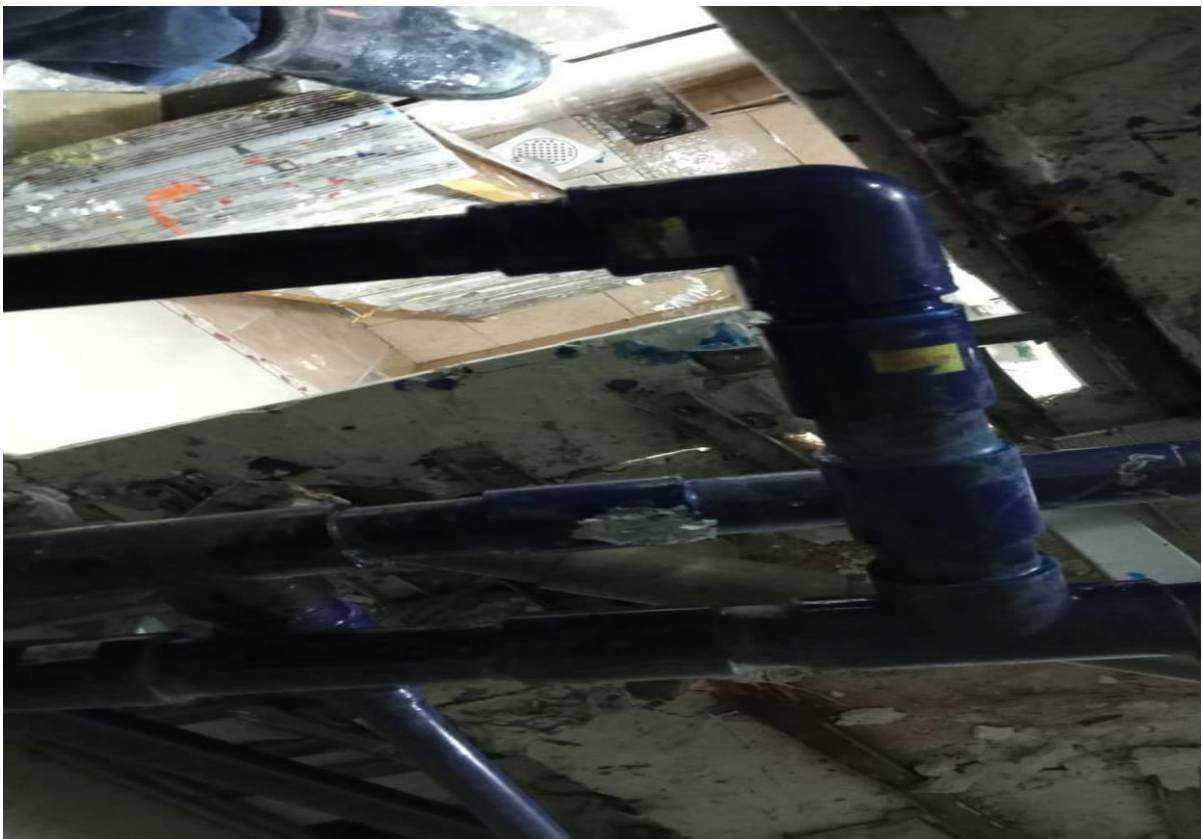
Gambar Diatas : Soket baru telah dipasang.. tunggu gam kering selama sehari..
