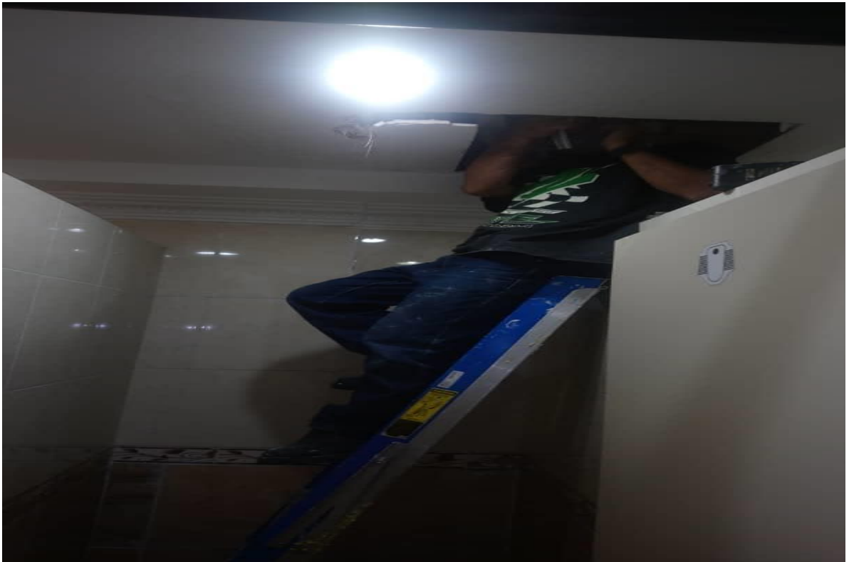
Gambar Diatas : Siling dibaikpulih – Gunakan kerangka aluminium
