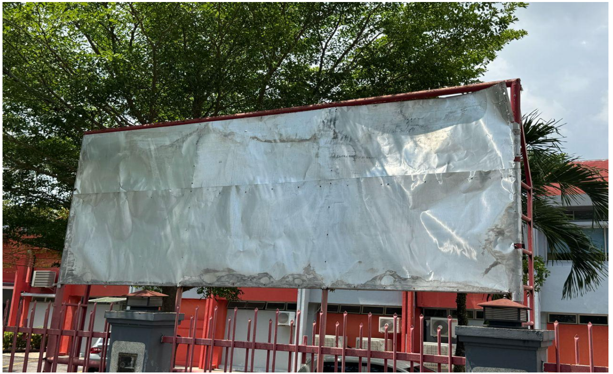
Pandangan hadapan : Plat reput dan terkoyak dari kerangka utama.
