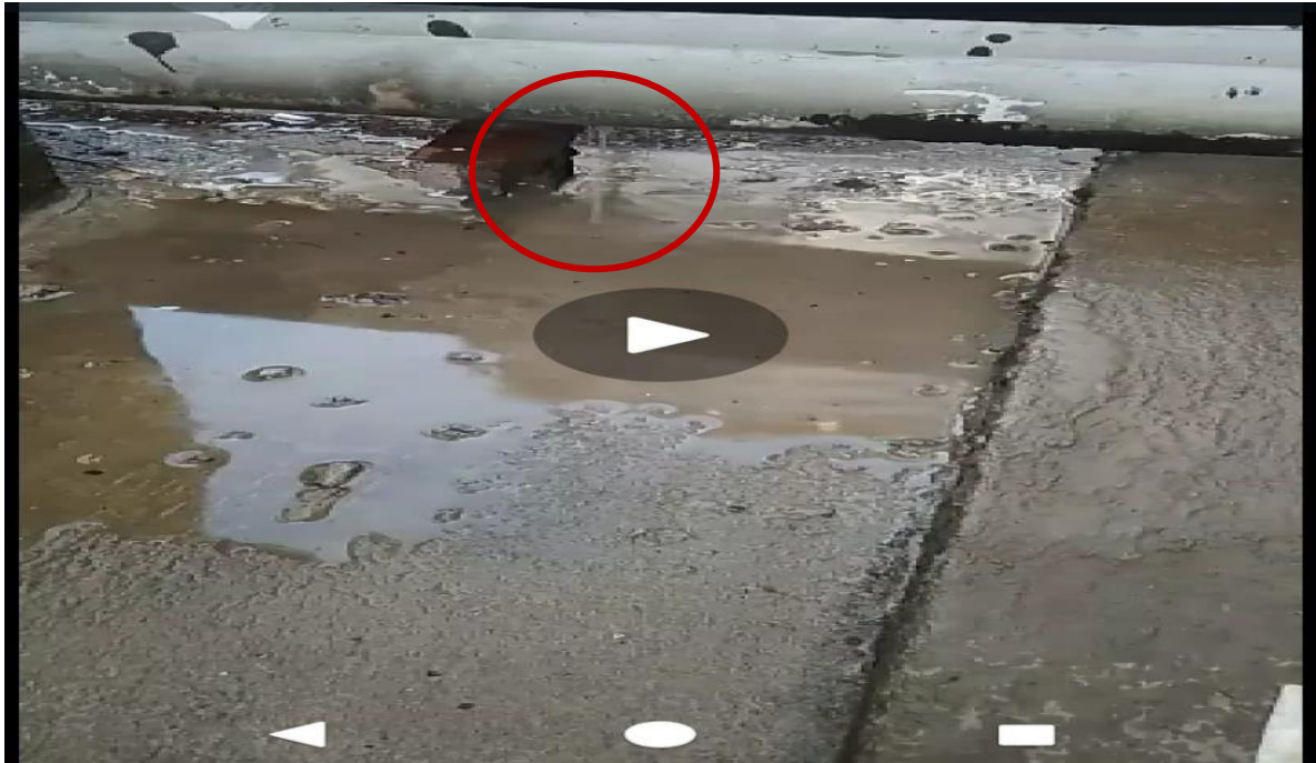
Gambar Di atas : Kebocoran paip utama (bulatan Merah)
