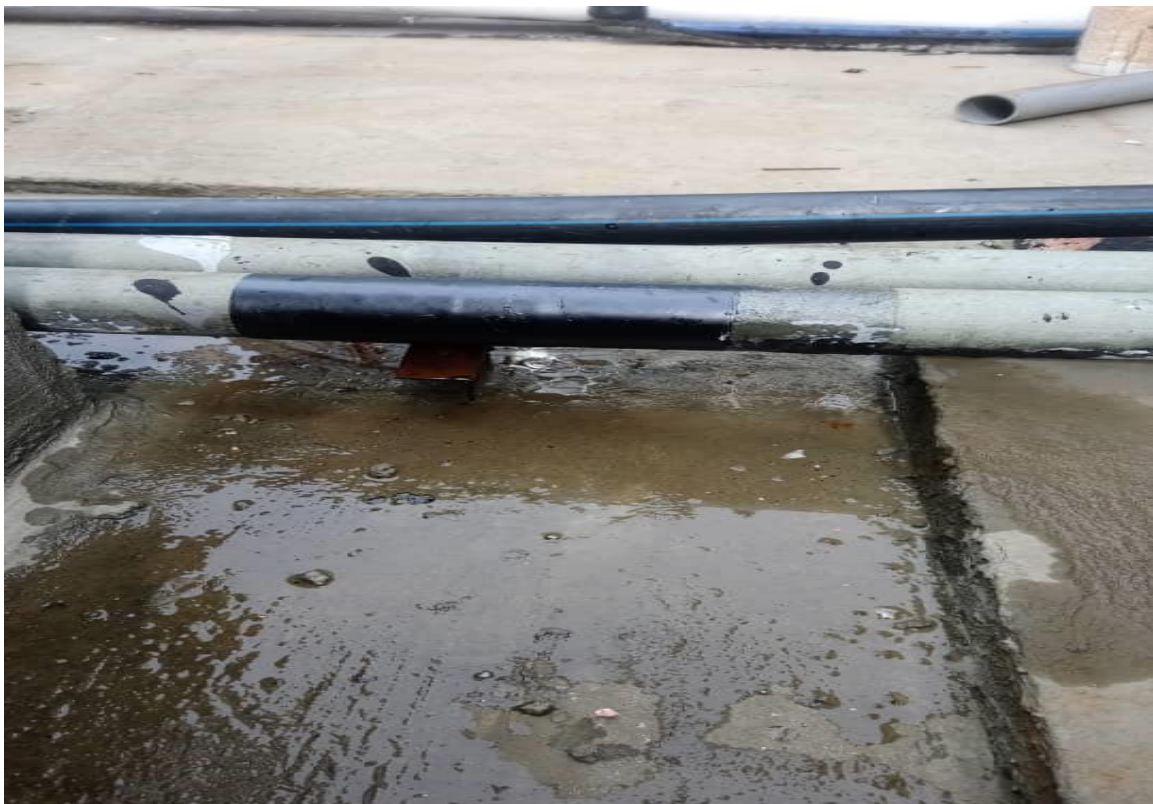
Gambar Di atas : Menggunakan Flex Tape untuk cuba menutup kebocoran tetapi tidak berjaya kerana tekanan air dari pam terlalu kuat
