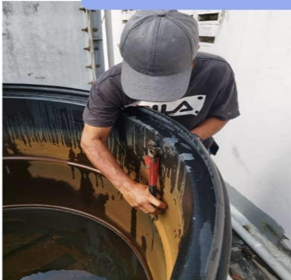
Buka Set Ball Valve Yang lama
